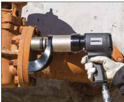
◀ La PTW1000 acelera los trabajos de mantenimiento de esta brida.
