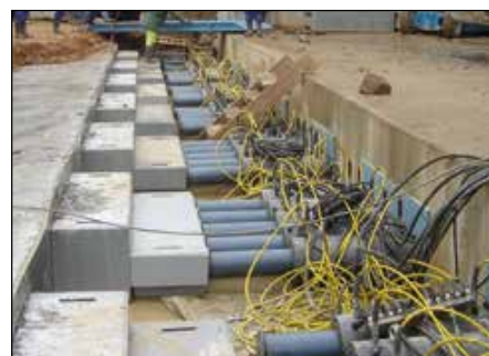
▲ Hincado de cajones: Sistema sincronizado de múltiples puntos para empujar hidráulicamente los segmentos del túnel por debajo del ferrocarril.
