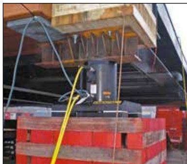
◀ Aplicación típica de elevación por etapas en la que se utiliza un sistema de Enerpac construido a la medida para levantar el puente de madera Akkerwinde de 360 toneladas en Holanda.
