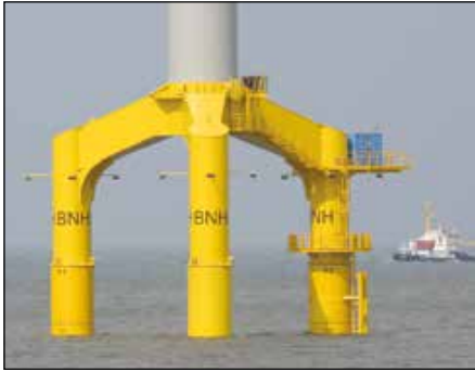
▲ Nivelación de turbinas eólicas marinas: El sistema de elevación sincronizada de Enerpac aportó la solución para nivelar los pilares de apoyo para las 80 turbinas eólicas.
